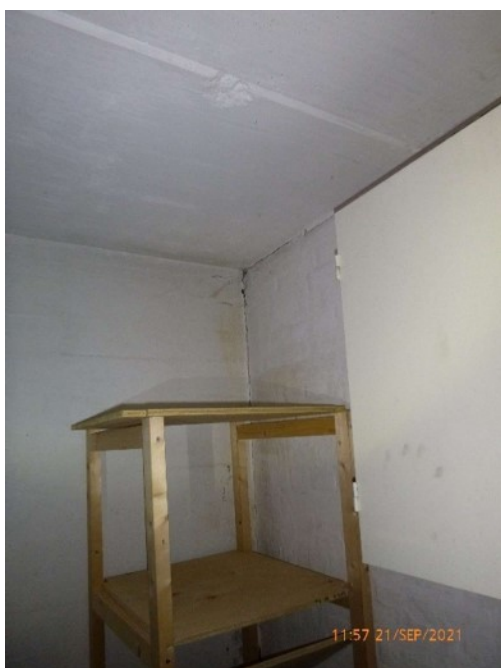
Foto 26. Reol i hjørnet af lagerrum 63. (Punkt 23)
