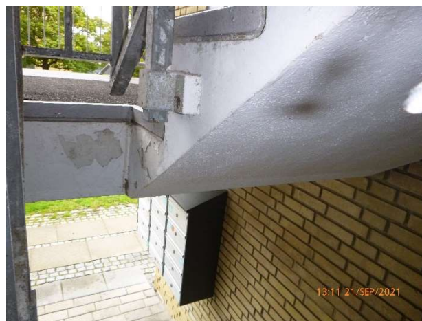
Foto 8. Trappevanger trænger til maling. (Punkt 7)
