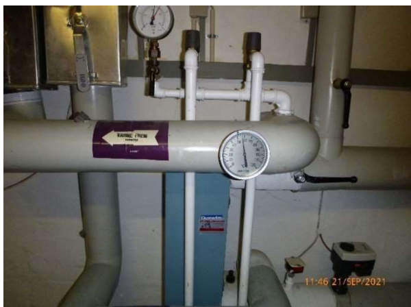
Foto 20. I fyrrummet ses, at der kun er 10 grader C afkøling. (Punkt 0)
