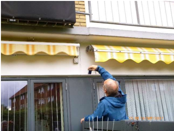
Foto 40. Lille betonafskalning (Punkt 23)
