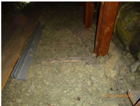
Foto 47. Der er trampet i isoleringen de steder, hvor der skal være adgang.
