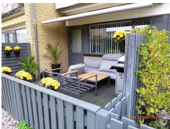
Foto 38. Ventilationsåbninger til kælder ligger sandsynligvis under terrassen. (Punkt 21)
