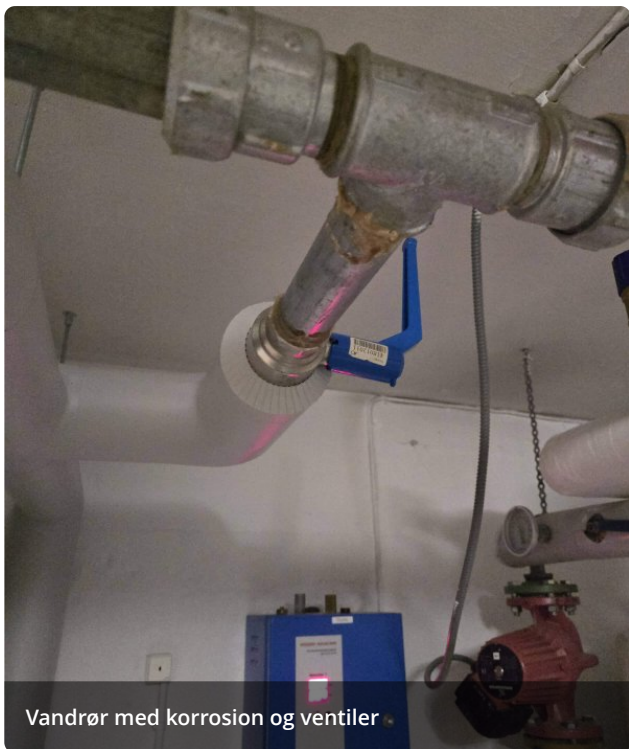
Vandrør med korrosion
