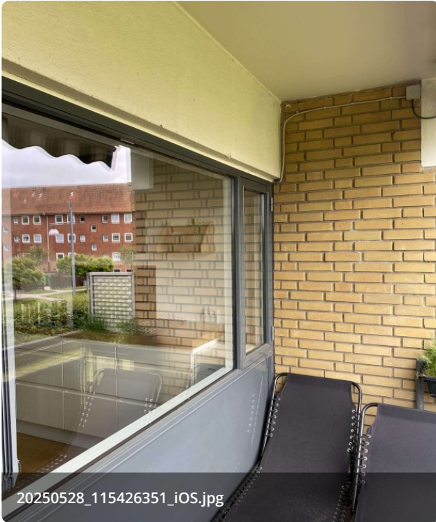
Vinduesparti mod haveside
