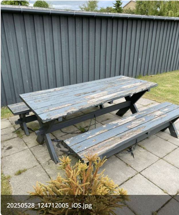
Malingslag på bænke fremstår afskallende
