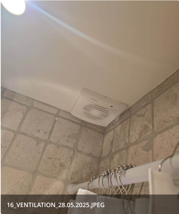
Ventilationsrist med tilsmudsning
