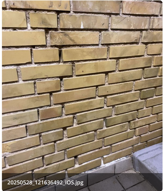
Porøse fuger i murværk ved kælder
