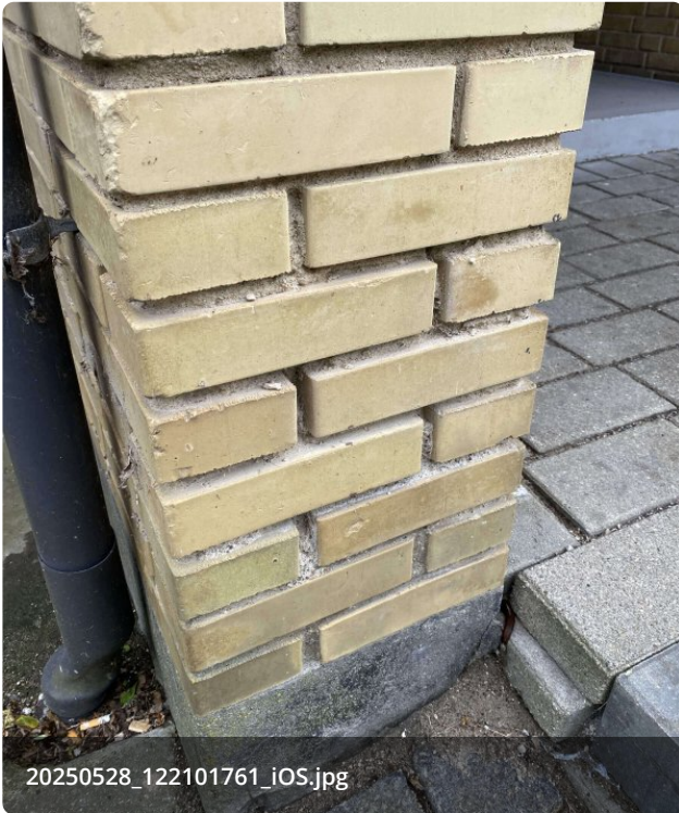
Porøse fuger i blankt murværk
