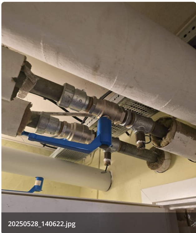
Korrosion og kalkaflejringer på vandrør
